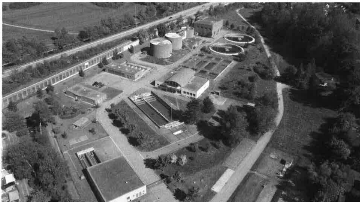
Anlage ARA Furt, Bülach
