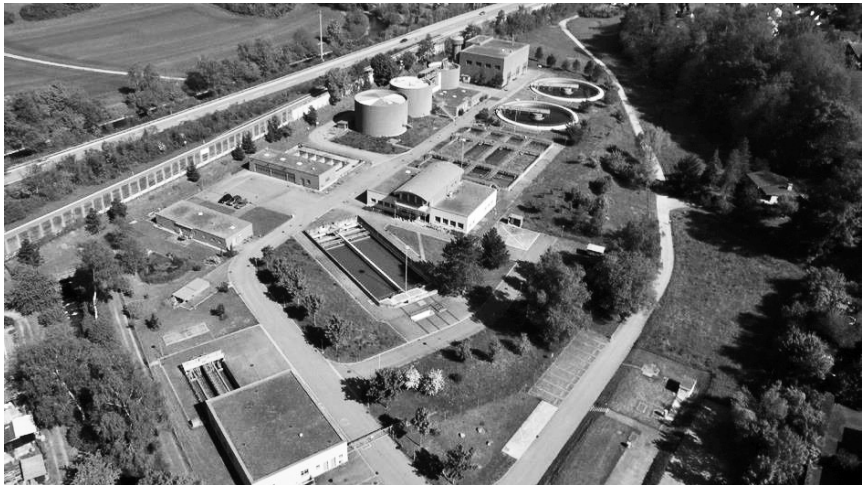
Anlage ARA Furt, Bülach
