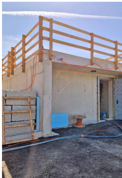
Neubau Reservoir Pumpwerk Breiti
